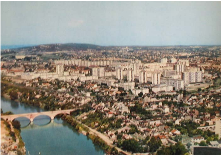
Voies SNCF vue des Berges de Seine Source : Archives Municipales d'Epinay sur Seine
