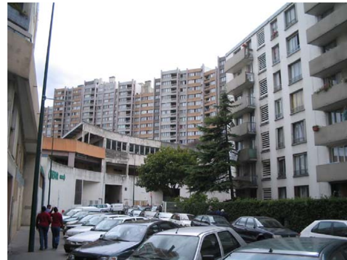
Photo 2- Rue du Général Julien après la réhabilitation
