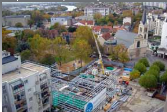
Septembre à décembre 2009 : pose de la charpente métallique et des planchers
