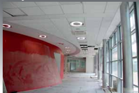
Novembre et décembre 2010 : aménagement des intérieurs
