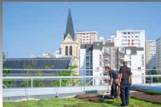
Février à octobre 2010 : travaux d'équipements intérieurs et finitions du bâtiment
