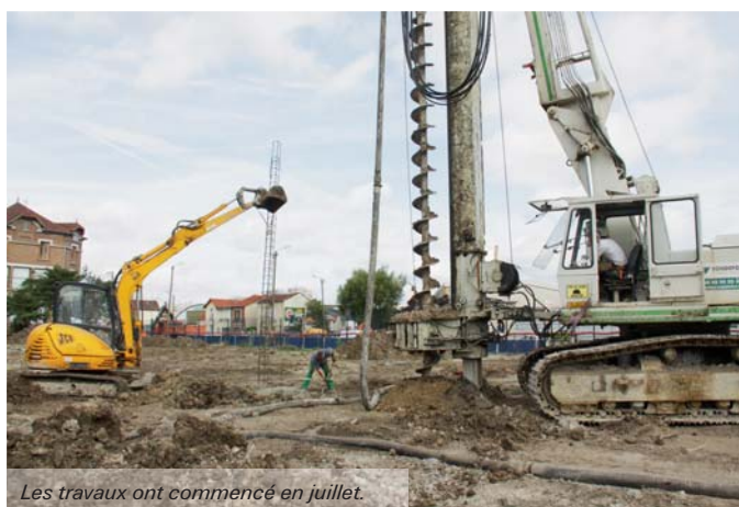
Les travaux ont commencé en juillet.
