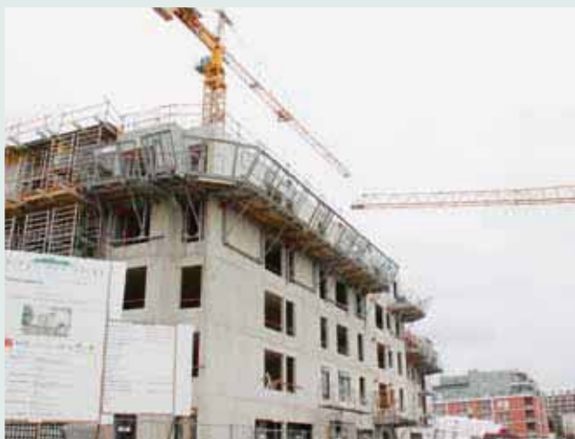
Le chantier de construction d'une résidence au 77, avenue d'Enghien, aux normes BBC.
