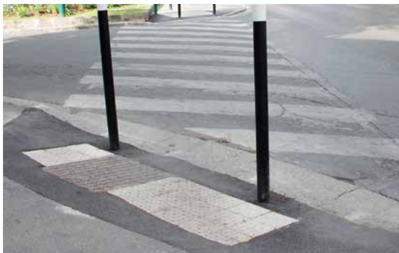
Route de Saint-Leu, les trottoirs seront abaissés au niveau des passages piétons.
