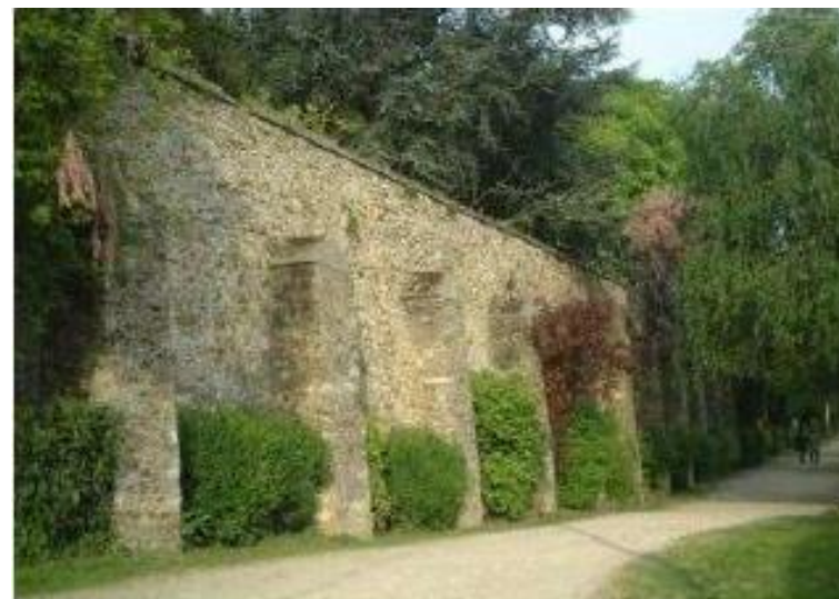
Mur de soutènement marquant une coupure entre les berges et les parcs (Source : la Trame Verte et Bleue de Plaine Commune, Juillet 2015)
