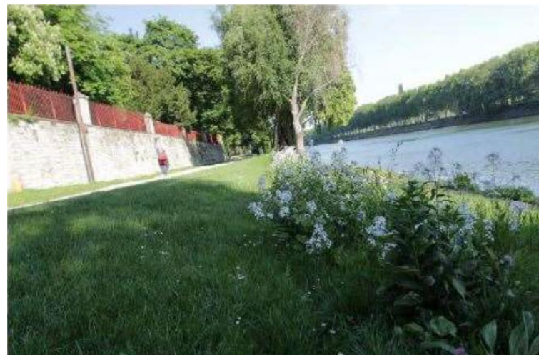
Mur de soutènement marquant une coupure entre les berges et les parcs (Source : la Trame Verte et Bleue de Plaine Commune, Juillet 2015)
