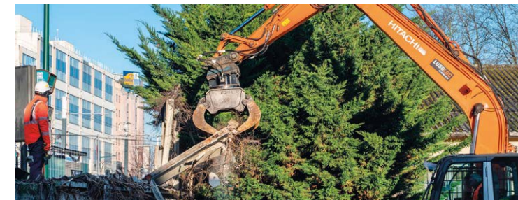
La démolition du mur d'enceinte
