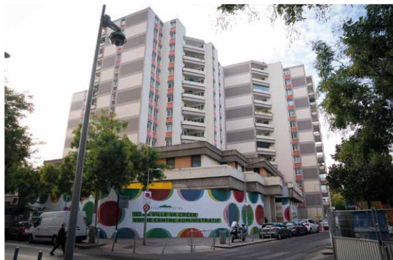
▲ Ancienne Poste - Futur centre administratif - Rue de Paris
