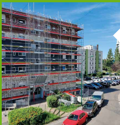
▲ Patrimoine de Clésence en rénovation - Rue d'Armentières
