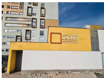
▲ Chantier de l'Espace Jeunesse Le Carré - Rue Maurice Ravel
