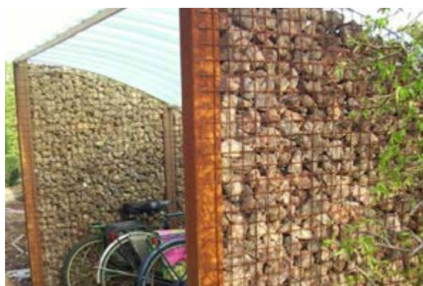
Parois d'abris-vélos en gabion
