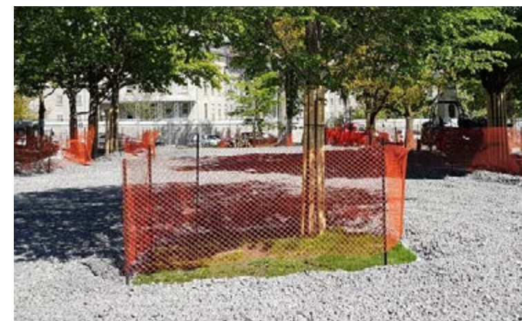
Protection d'un arbre durant un chantier
