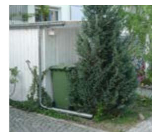
Irrigation des massifs devant les logements privés par l'eau de toiture des cabanons
