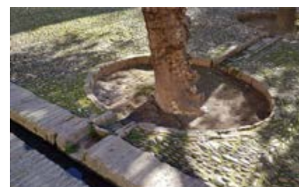
Irrigation des pieds des arbres par l'eau de pluie - Espace public, Cordou
