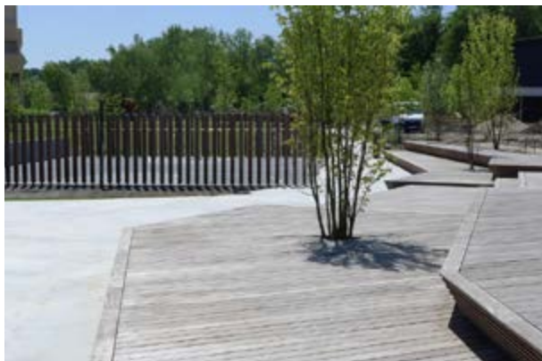
Platelage à gradins en ville
