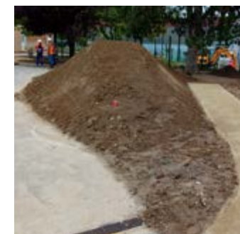
Réutilisation sur site de la terre de déblais en butte plantée. École de la Justice, Cergy
