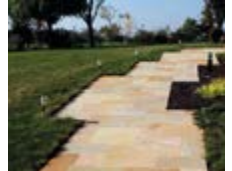
dallage avec joints perméables : 0,9
